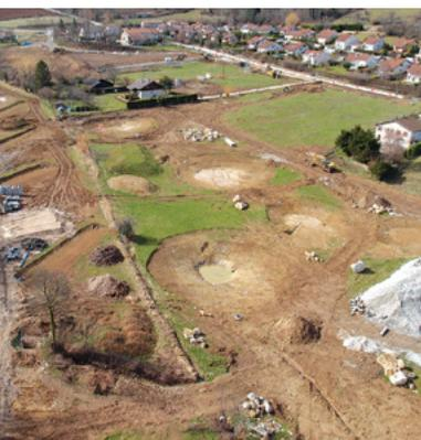
› Les lentilles et gouttières de rétention et d'infiltration d'eau, sont déjà visibles sur le chantier Pré Nouvel.
