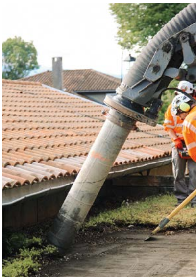
Travaux préparatoires sur la toiture de l'école maternelle Blanche-Rochas en amont des travaux d'étanchéité.
