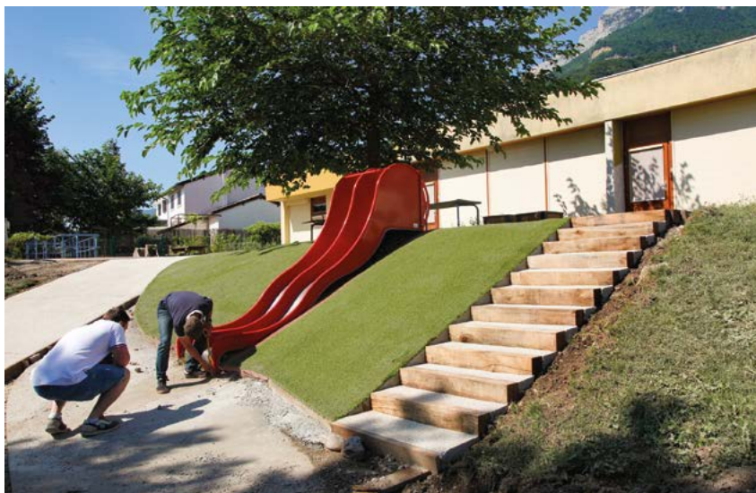
Aménagement de la cour de l'école maternelle du Priou avec la création d'un cheminement en béton désactivé, la sécurisation des jeux avec la pose de sols souples et l'installation d'un escalier.
