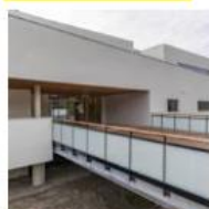
FIN DE LA CONSTRUCTION DU CENTRE DE TRI
