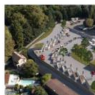
DÉMARRAGE DES TRAVAUX DE LA DÉCHÈTERIE DE GRENOBLE JACQUARD
