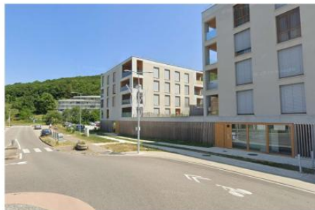
Aménagement des trottoirs le long de l'avenue de Claix
