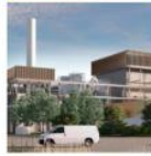
LE PROJET DE CONSTRUCTION DE LA NOUVELLE UIVE AVANCE
