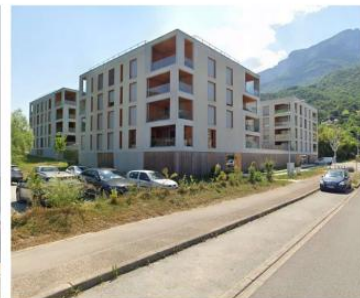
Aménagement des stationnements et espaces verts
