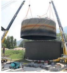
L'inspection décennale des digesteurs d'Aquapole (été)
