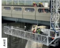
À l'occasion des vacances de printemps, la circulation des véhicules a été interdite sur le pont berge de Saint-Egreve pour permettre la pose des supports en INOX, en attente de la mise en œuvre, en juillet, de la conduite DN 400.
