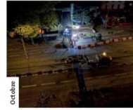
Des travaux de nuit sur le Cours Jean-Jaures pour créer un maillage de réseau d'eau potable, en coordination avec les travaux de réaménagement de l'échangeur routier du Rond-Point.
